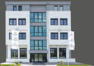
Firmensitz der BRUTSCHIN WOHNBAU in Waiblingen bei Stuttgart.
